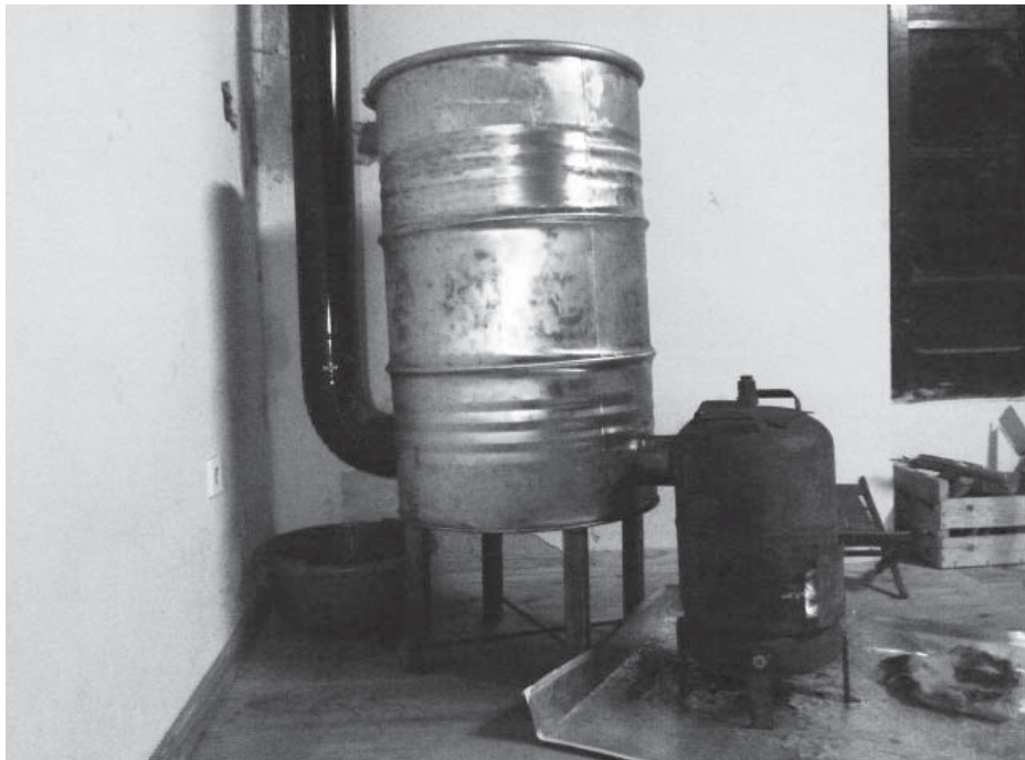
Nuestra estufa con un intercambiador de calor... pero esto ya es otra historia...
